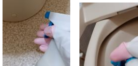
便器と床の立ち上がり部分
